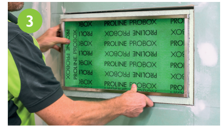
3 Mit geeignetem Material PROBOX einkeilen, einmessen und ausrichten.
