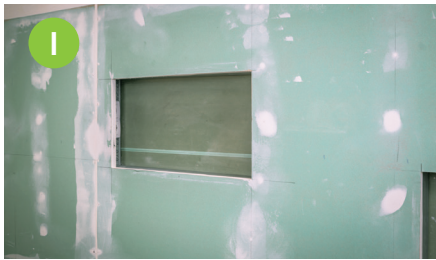
1 Wandnische nach Einteilung der Fliesen sowie Berücksichtigung des Rohbaumaßes der PROBOX erstellen.
