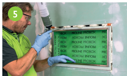
5 Nach Aushärtung der Fixpunkte verfüllen und den Montageaum ausspachteln.
