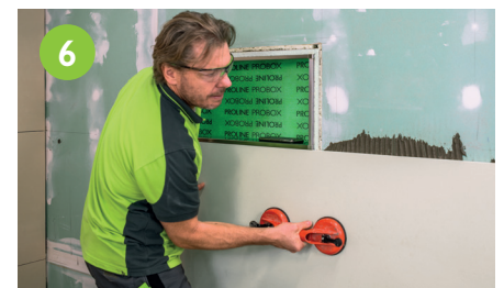
6 Wandfliesen an die PROBOX verlegen.
