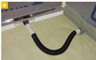
Zur schnelleren Montage empfiehlt sich IndorTec® FLEXDRAIN-FR Flexrohr mit 75 cm Länge. Der korrekte Rohranschluss und die Wasserableitung sind vor dem Estrich einbau zu überprüfen.
