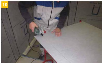
Um einer Rissbildung, geschuldet der geringen Rohrüberdeckung, entgegenzuwirken, ist die Lastverteilerplatte oberhalb des Estrichs einzubauen. Diese wird mit Winkelschneider oder Stichsäge zugeschnitten...
