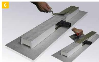
Vor dem Setzen der Rinne wird unterseitig Klebemörtel aufgetragen um eine Verkrallung zum Estrichmörtel, bzw. um eine vollflächige Auflage sicherzustellen. Insbesondere zum direkten Verkleben kann ein Aufzahn zweckmäßig sein.
