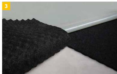
Zur Trittschallreduzierung die IndorTec® FLEXDRAIN-SM Schallschutzmatte auslegen. Die Matten werden mit den Noppen nach unten verlegt und anschließend mit PE-Folie abgedeckt.
