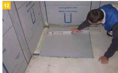
Beim Einsatz der Lastverteilerplatte muss die Estrichabziehkante 4 mm in der Höhe bauseits gekürzt werden. Rückseitig Klebemörtel auf die Lastverteilerplatte auftragen. Dann „Frisch in Frisch“ in den Estrichmörtel einarbeiten und ausrichten. Eine Schwächung des Estrichs kann so sicher überbrückt werden.
