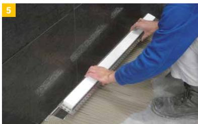
Der Einbau des Drainrahmens und des höhenverstellbaren Fliesenrahmens erfolgen zum Abschluß vor der Belagsverlegung. Winklige/parallele Ausrichtung an Fliesenfugen und Wandanschluß sind bis +/- 5 mm möglich.
