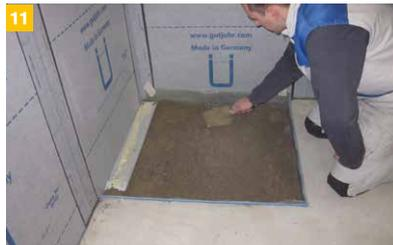
Zur einfachen Verarbeitung kann der Estrich an der Estrichabziehkante höhengenaue abgezogen werden. Es ist darauf zu achten, die Duschrinne mit dem Estrichmörtel fest zu verbinden. Hierzu ist eine Haftkontaktschicht aufzubringen.
