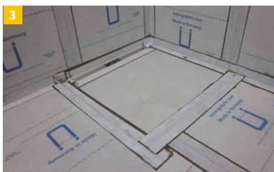
Fertig zur Fliesen- bzw. Natursteinverlegung. Wird die IndorTec® FLEXDRAIN-HD auf Podeste eingebaut, muss an allen Rändern ein Aufkantungswinkel (nach ZDB-Merkblatt „Verbundabdichtungen“ eingedichtet werden.
