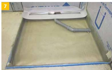
Abflussrohre DN40 an die Duschrinne anschließen. Ein Mindestgefälle von 1 % ist einzurichten. Ein etwaiger Adapter DN40/DN50 ist an die bauseitige Abwasser-Installation unmittelbar vor dem Wandanschluss zu montieren. Ggf. sind die Rohre mit einer Schallsisolierung zu ummanteln.
