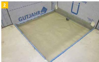
Untergrund für Estrich einbau fachgerecht vorbereiten (Randdämmstreifen, etc.)
