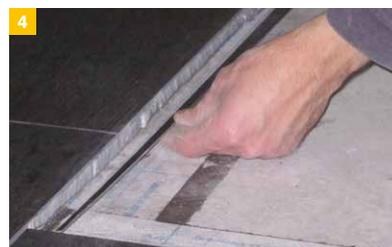
Nach Verfliesung des umfassenden Bodenbelages am Duschbereich, das Gefälleprofil entsprechend ablängen und mit DiProtec® FIX-MSP Dicht-Klebstoff an der/den freien seitlichen Wangen der Estrichaussparung ankleben. Der wandbündige Einbau ist bei dieser Duschrinne möglich.
