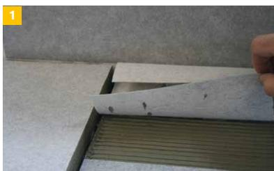
Die dichte Einklebung von Dichtmanschette an Boden ...
