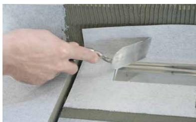
...und Wand erfolgt mit Dichtkleber (z. B. Ardex 7+8 Dichtkleber).
