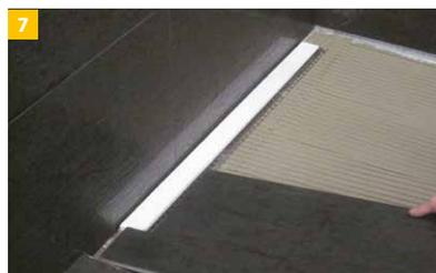
Die Fliesenverlegung auf der IndorTec® FLEXDRAIN-LP Lastverteilerplatte ist ohne Formatbeschränkung möglich.
