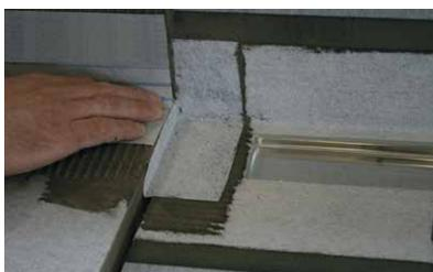
...sowie alle Dichtbänder mit dem IndorTec® SEAL-DK Dichtkleber eingeklebt bis der Duschbereich mit allen Boden- und Wandflächen komplett eingedichtet ist.
