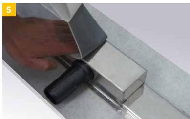
Falls notwendig, kann der Rinnenträger entfernt und das Butylband unterseitig an den Rinnenkörper geklebt werden.
