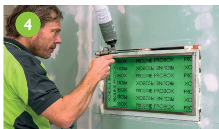
4 Wahlweise mit Fliesenkleber oder Montage-schaum fixieren und befestigen.
