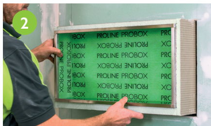
2 Einpassen der PROBOX in Nischenöffnung.
