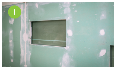
1 Wandnische nach Einteilung der Fliesen sowie Berücksichtigung des Rohbaumaßes der PROBOX erstellen.
