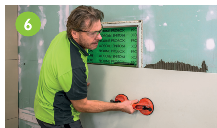
6 Wandfliesen an die PROBOX verlegen.
